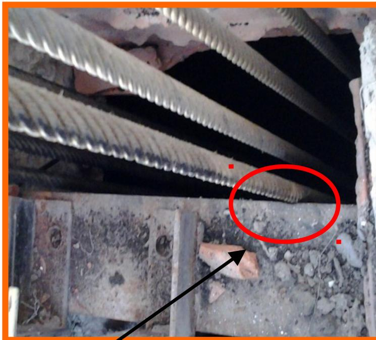
INTERFERENCIA DE LOS CABLES DE TRACCION CON LOS HIERROS DE LA LOSA Y PERFILERIA
