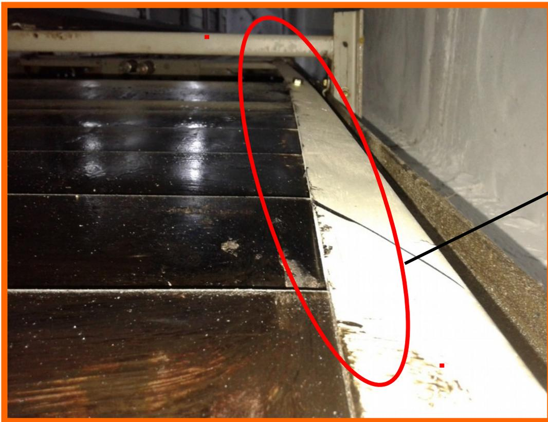
DEFORMACION DEL BASTIDOR POR MALA INSTALACION DE UN LINGOTE DE CONTRAPESO
