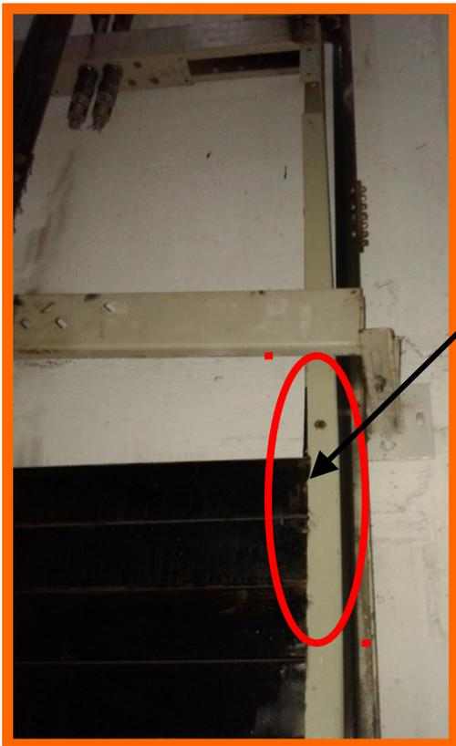
DEFORMACION DEL BASTIDOR POR MALA INSTALACION DE UN LINGOTE DE CONTRAPESO
