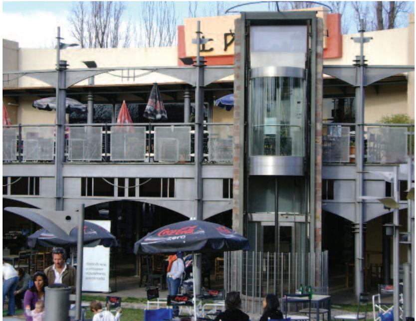
Debe tenerse en cuenta que si bien estos elevadores no llevan máquina de tracción, ya que su funcionamiento depende de la central oleodinámica, su sala de máquinas debe estar perfectamente dimensionada y habilitada para la instalación de la central y el control de maniobras.
